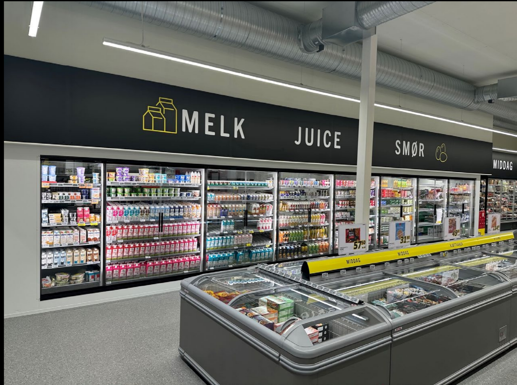
Fra installasjon til ferdig butikk. Rørstrekk kan også skjules bak baldakin
